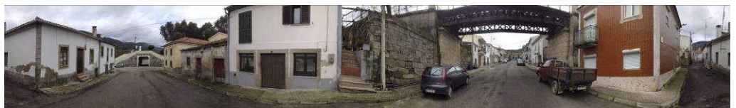
Ilustração 7 - Rua da Pedriça - Ponte ferroviária e cruzamento com Travessa do Silho
