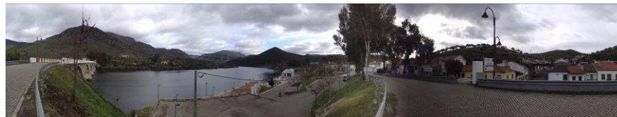
Ilustração 5 - Ponte Almirante Sarmiento Rodrigues, EN221
